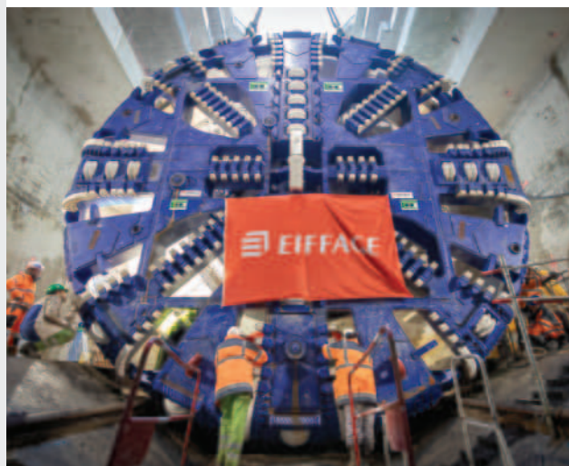
Grand Paris Express (Frankrijk) — Tunnel
