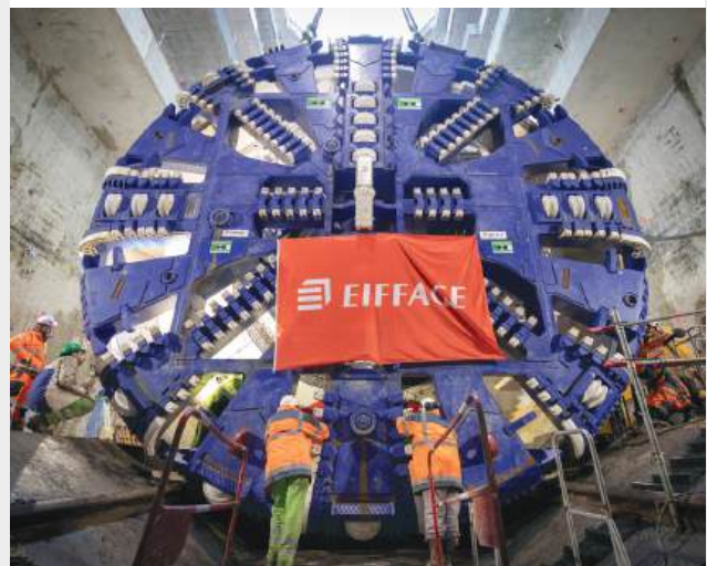
Grand Paris Express (Frankrijk) — Tunnel
